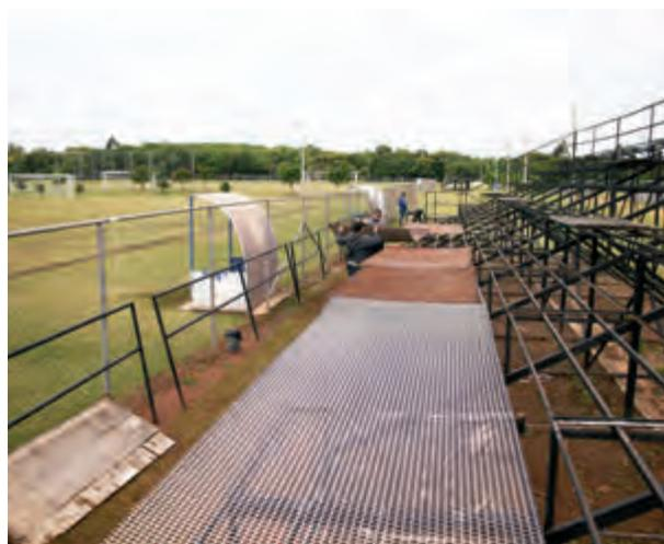
En el marco de dicha competencia, se realizaron mejoras como la reforma completa de las graderías móviles situadas en el predio, por lo que se reemplazaron todas las huellas de las graderías de metal desplegable por huellas de chapa antideslizante, mejorando sustancialmente el confort y la seguridad de los espectadores.
